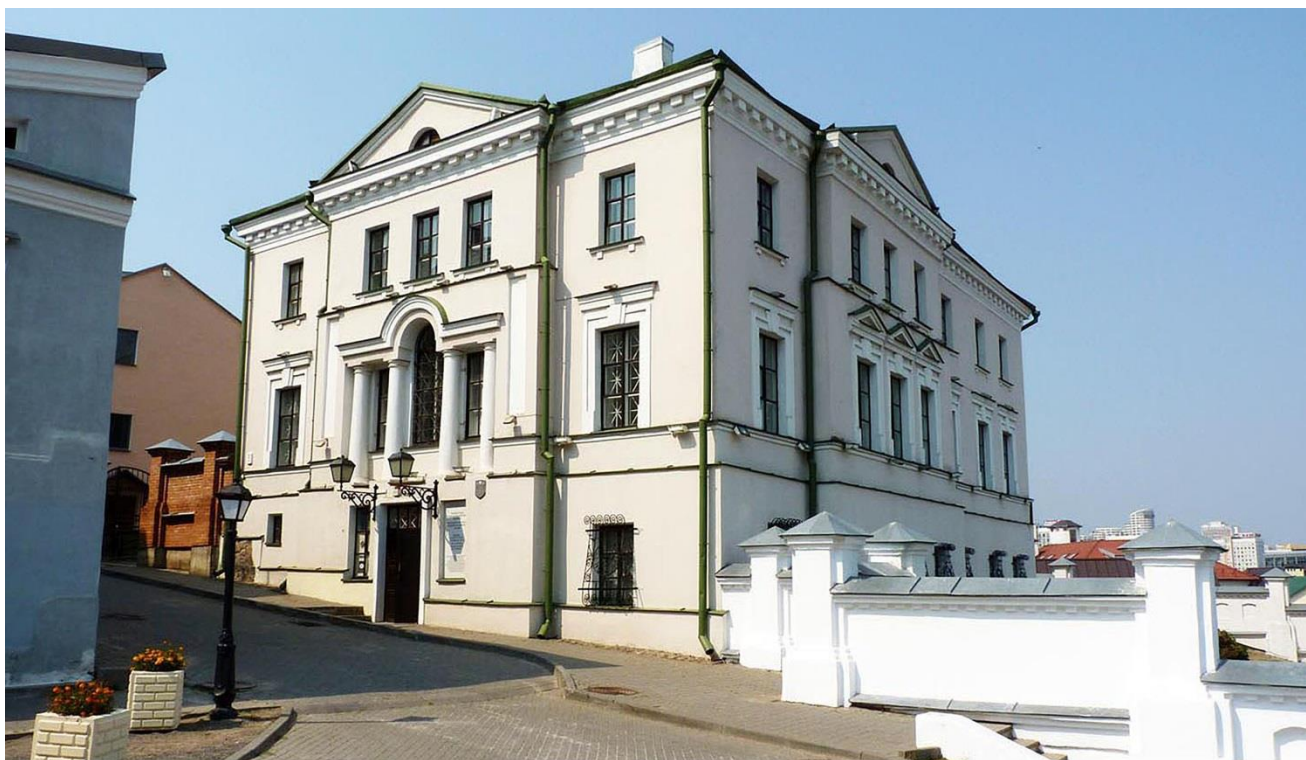
Дом на пер. Музыкальном 5 после реставрации. Арх. В. Старостин
