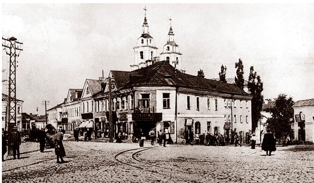
Комплекс жилых домов 18 – нач. 19 вв. на пл. Свободы 19,21. Фото начала 20 века
