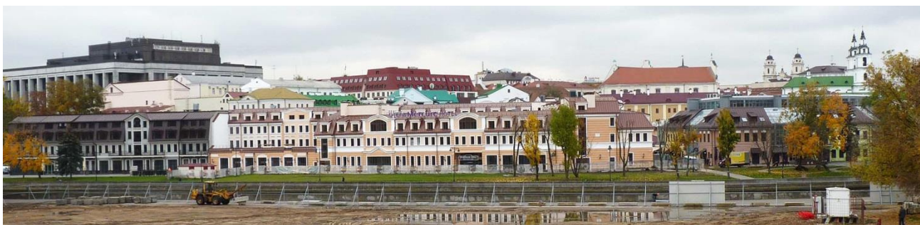
Вид с набережной на застройку участков № 2, 3 и 4
