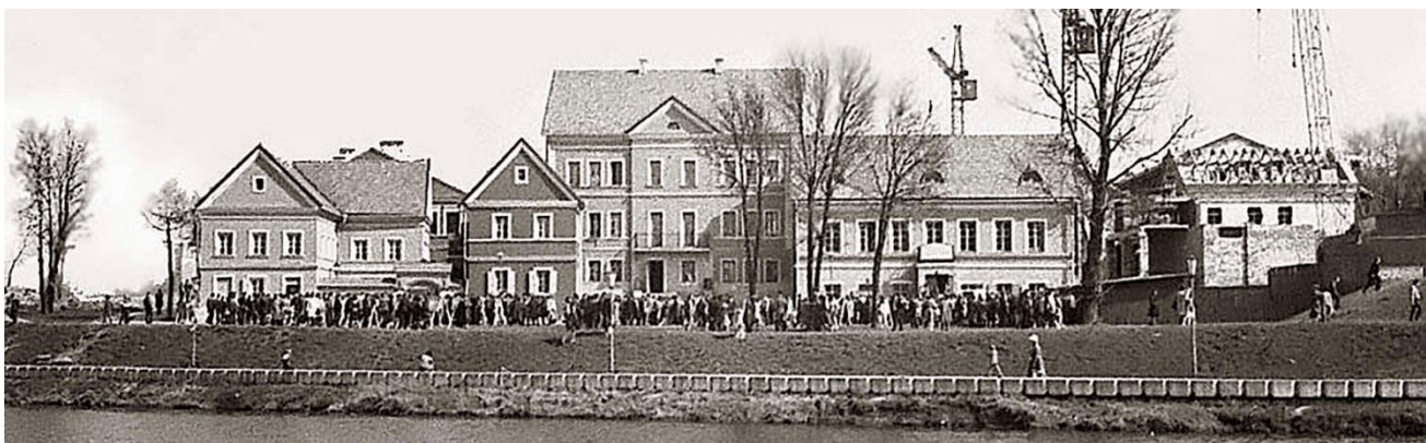
Троицкое предместье в 1982 году. Первая очередь реконструкции
