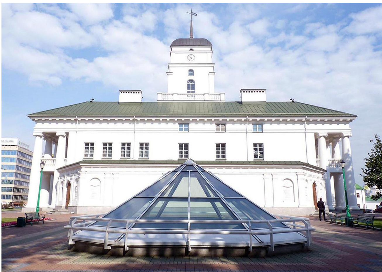
Световой фонарь подземного зала универсального назначения
