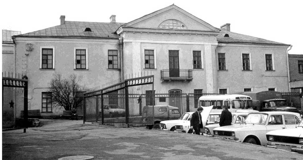
Фотография здания до реставрации
