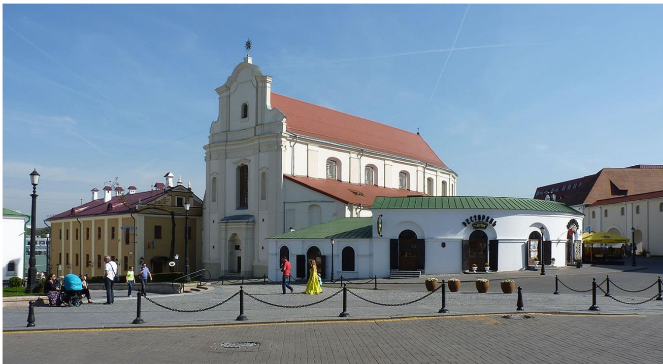
Общий вид гостиницы с пл. Свободы после реставрации
